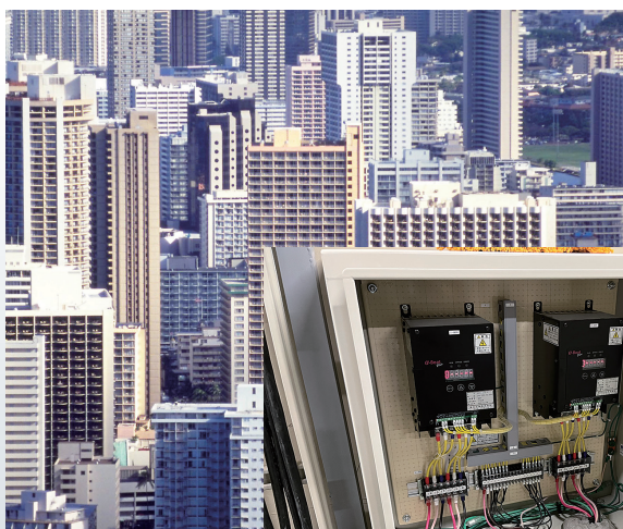
既設直入制御盤とポンプモーターの間に設置しました
