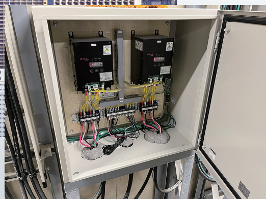
既設直入制御盤とポンプモーターの間に設置しました
